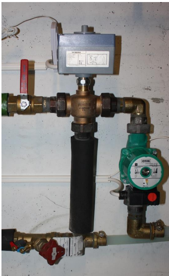
Figur 28 (Bilde: ukjent) Bruk av shuntventil for nedblanding av temperatur. Dette er løsningen som vises nederst til venstre i neste figur.
