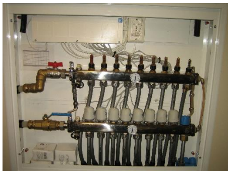
Figur 23 (Bilde: ukjent) Eksempel på fordelerskap til gulvvarme med romregulering og styring per kurs.
