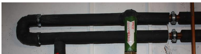
Figur 22 (Bilde: ukjent) Samlestokk med åpen bypass. Dette krever både hovedpumpe og sekundærpumpe og dette vil gi en høy returtemperatur til varmesentralen.
