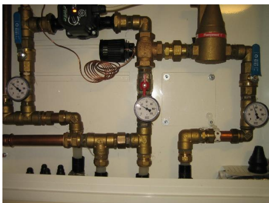
Figur 21 (Bilde: ukjent) Eksempel på en kursoppbygging med kun fast temperatur på turvannet.
