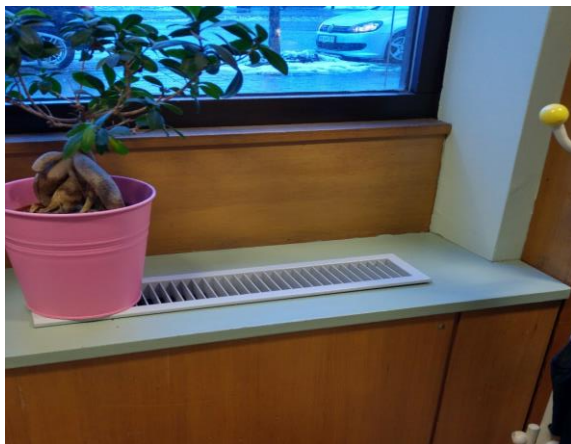
Figur 25 (Bilde: David Zijdemans) Innkassing av radiatorer.
